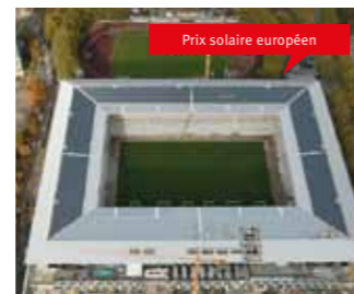
Stade de Suisse Berne Année de construction 2005/2007 Puissance 1 350 kWp
